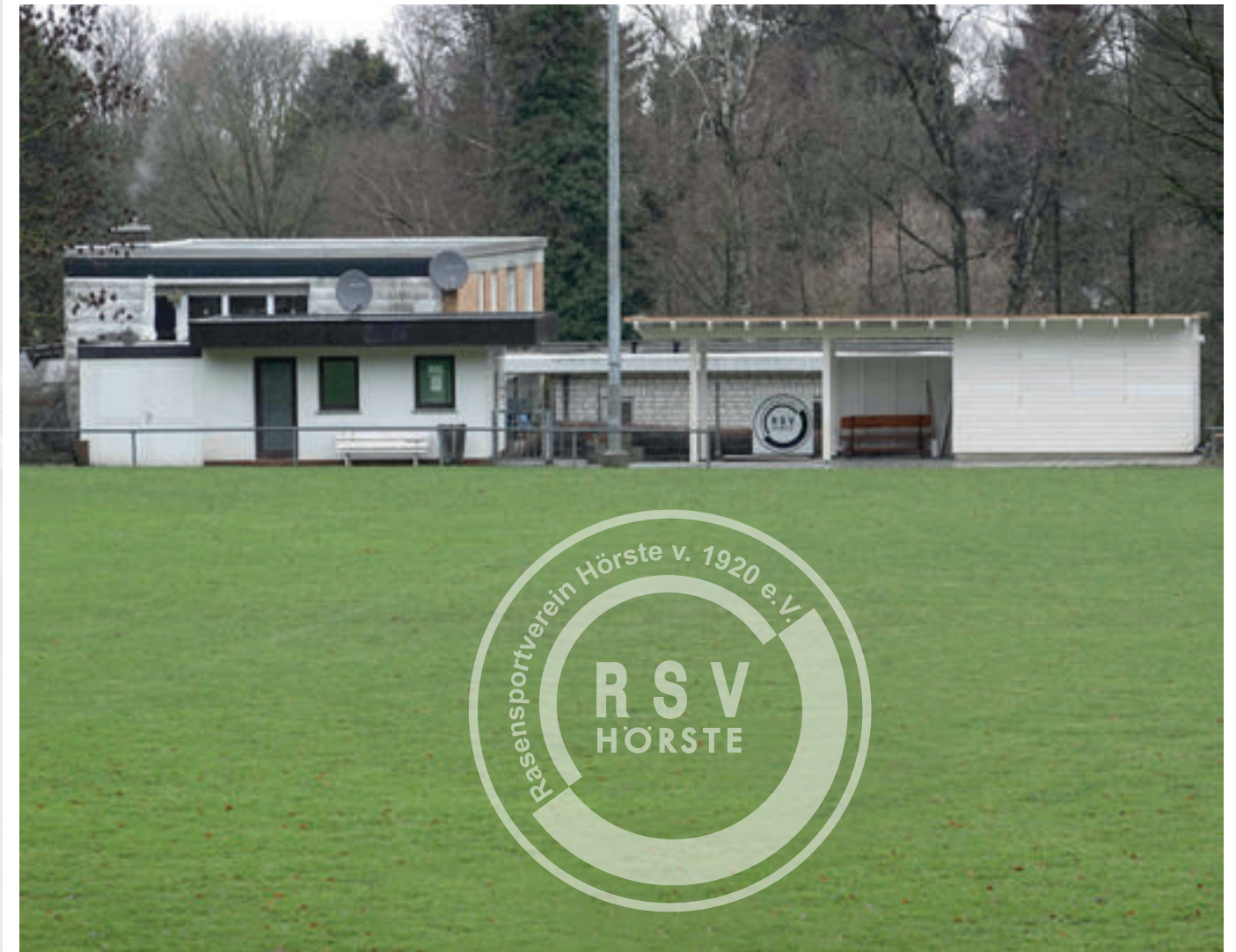
Ein Blick auf den neuen Vielzweckraum rechts im Eingangsbereich; Stand 27.1.2019.
